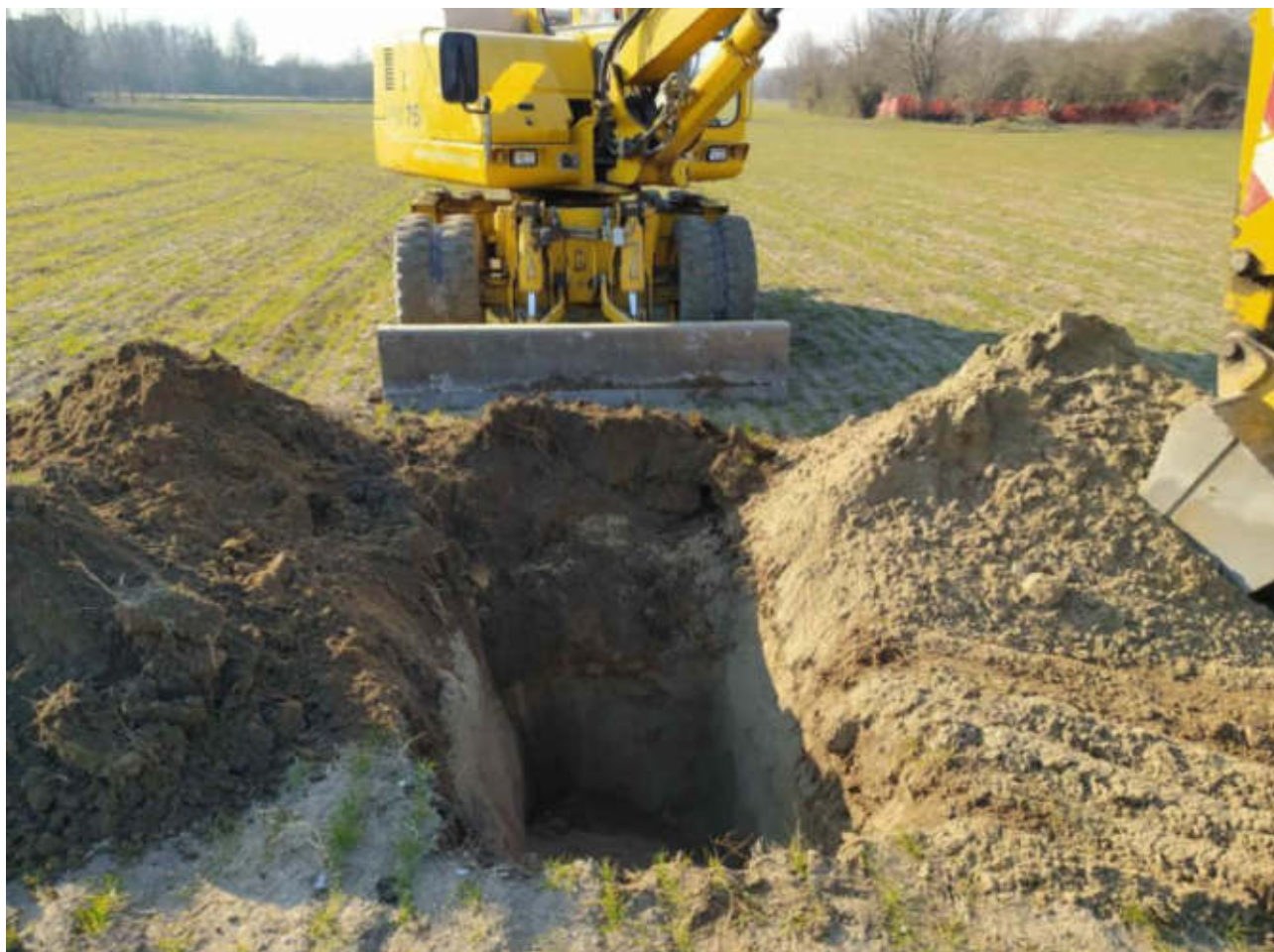
Figura 2 – Sondaggio con escavatore P4 (cfr. Relazione geologica R.4)
